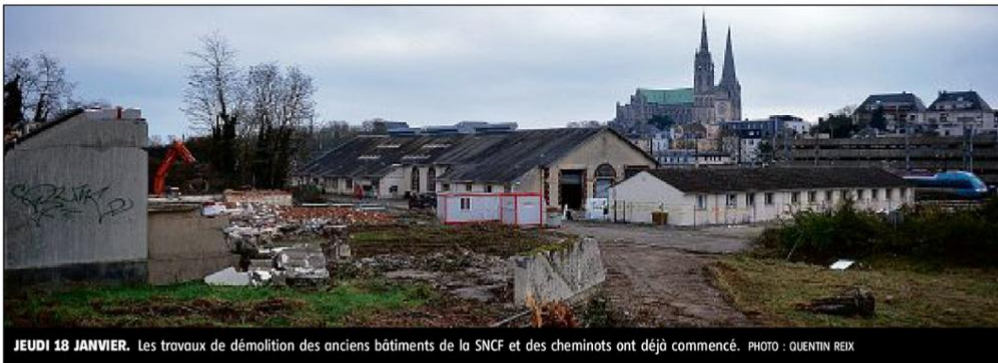
JEUDI 18 JANVIER. Les travaux de démolition des anciens bâtiments de la SNCF et des cheminots ont déjà commencé. PHOTO : QUENTIN REIX
